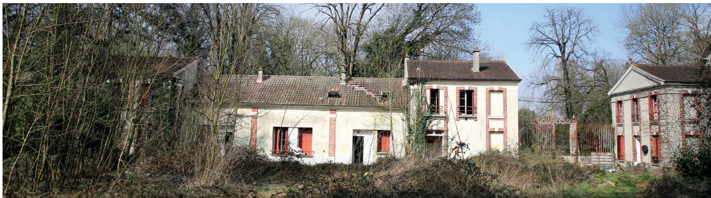
État actuel du site, façades intérieures, côté route de Versailles
